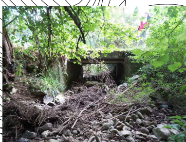
Stazione 2 Confluenza della v. Foppa nel Gavarnia. Presenza di materiale destrucito, ramaglie e reti metalliche
