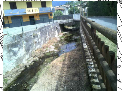
Stazione 14/1 Vegetazione e materiale in alveo a monte Piazza Rinnovata
