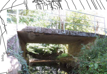
Stazione 13/1 Vegetazione e materiale in alveo a valle ponte cimitero Gavarno
