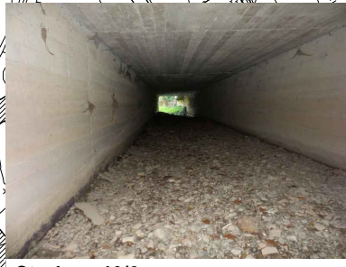
Stazione 10/6 Deposito materiale nella tombinatura ditta Co.Ver.Lac
