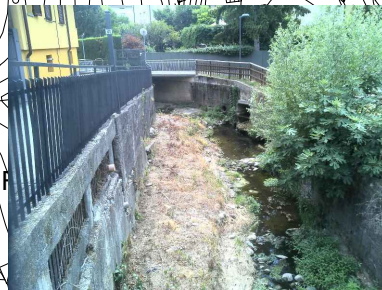
Stazione 14/2 Vegetazione e materiale in alveo a monte Piazza Rinnovata
