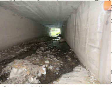
Stazione 10/6 Deposito materiale nella tombinatura ditta Co.Ver.Lac
