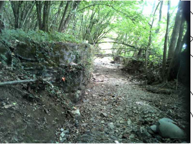
Stazione 9/1 Rami trasversali all'alveo
