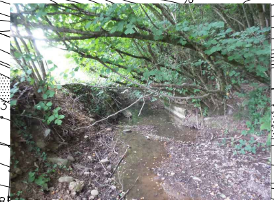
Stazione 1 Erosione alveo e sponda destra. Muretto in cls scalzato in sponda sinistra e piante schiantate.
