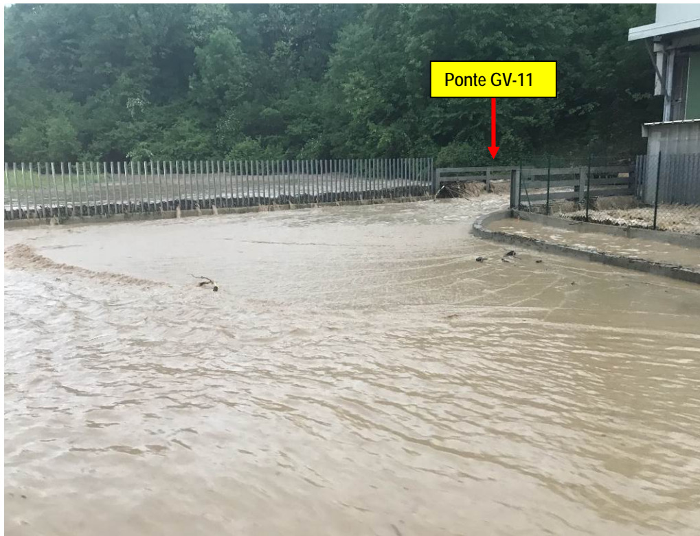
Foto 6 Officine Gavarnia: situazione in corrispondenza del ponte GV-11 con tracimazione in sponda destra
